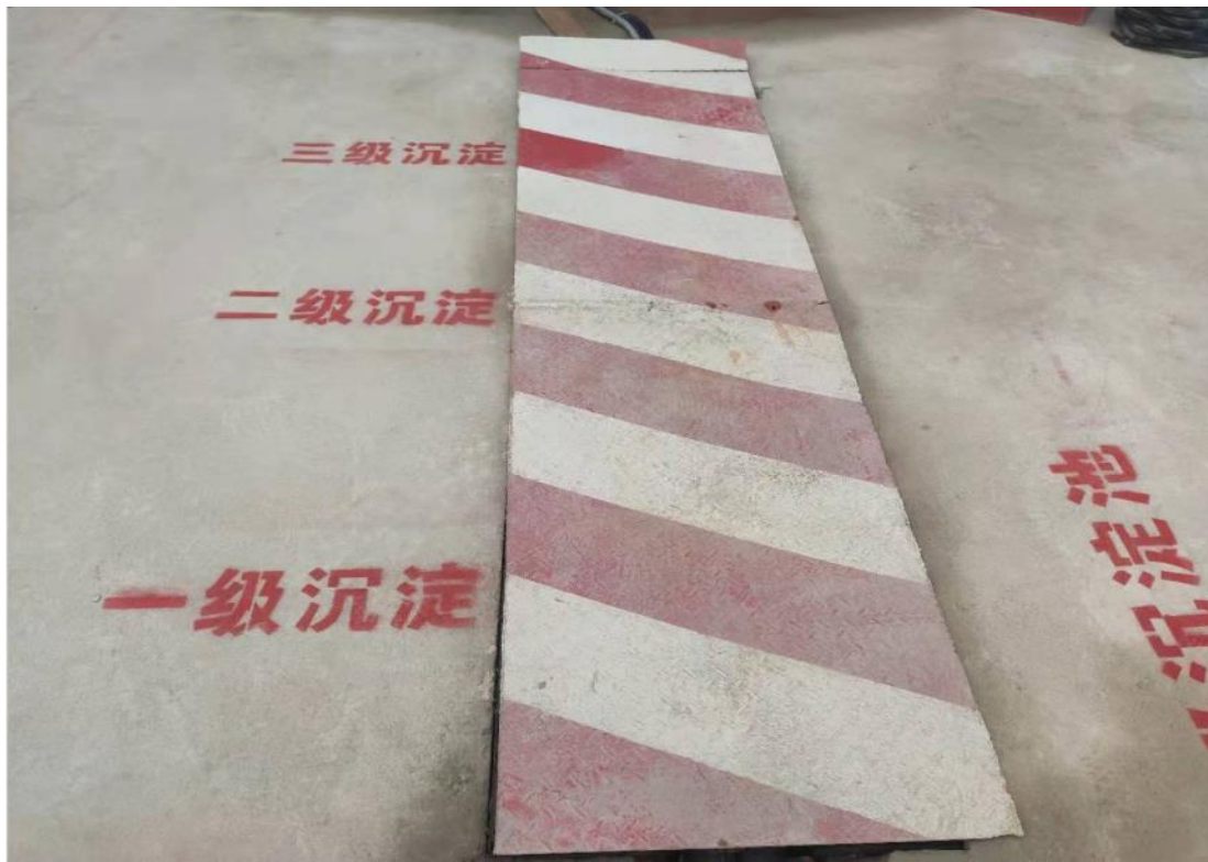
对地表水进行回收、沉淀
