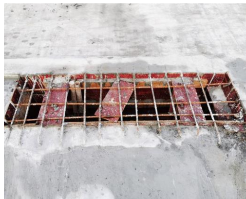
水平洞口钢筋网片
