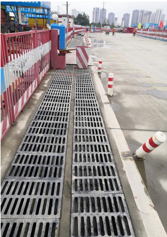
道路旁设置排水沟
