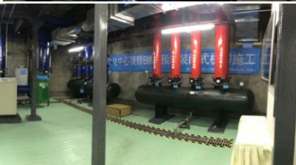
机房模块装配式安装
