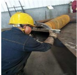
管道法兰工厂水平度检查
