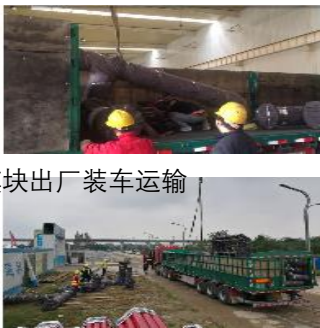
管组模块现场卸车转运
