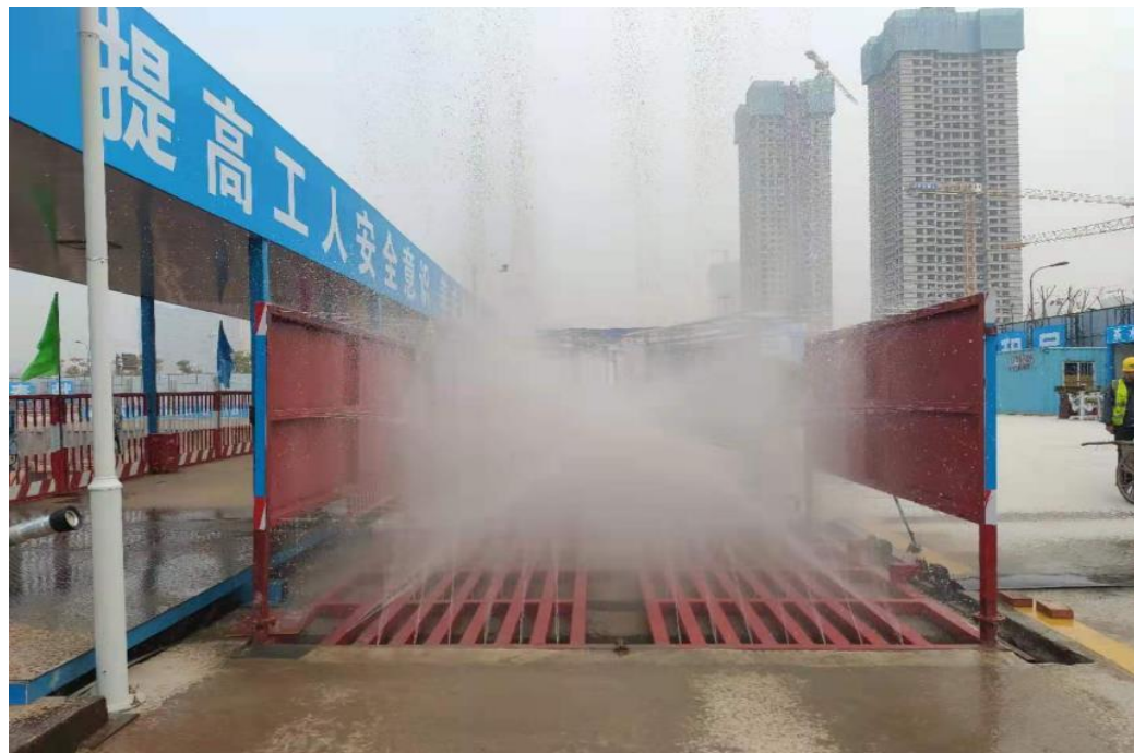
出工地车辆冲洗车轮
