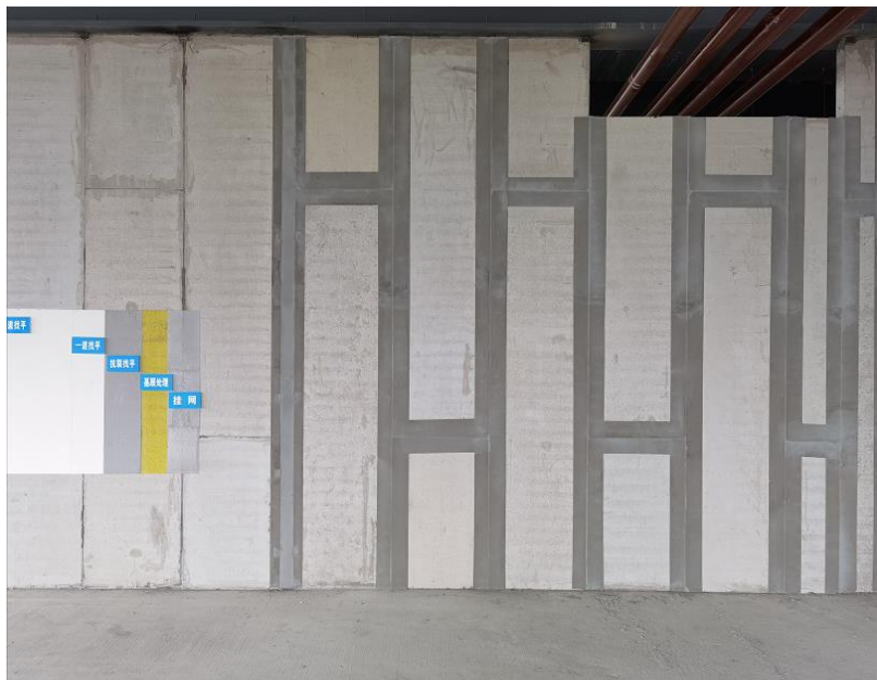
复核轻质隔墙板施工
