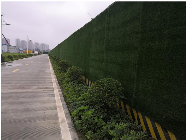
施工现场隔音降噪措施
