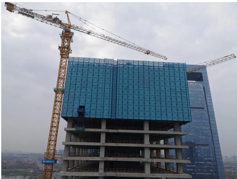
施工现场隔音降噪措施
