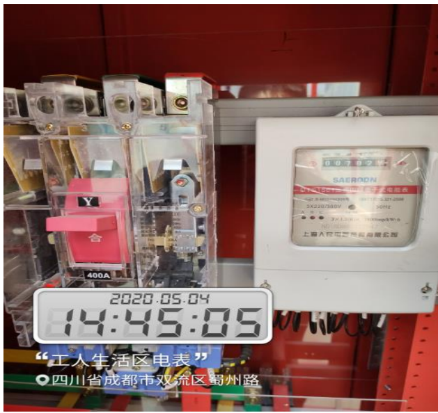
变频塔吊并设置独立电表
