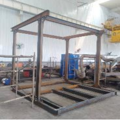
水泵槽钢框架预制拼装
