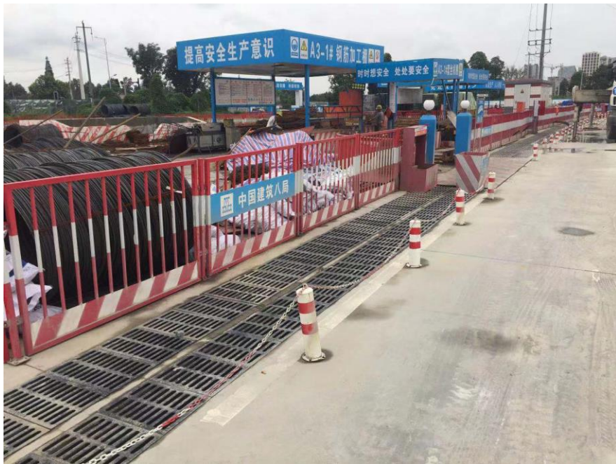
堆放材料场地周围设排水沟
