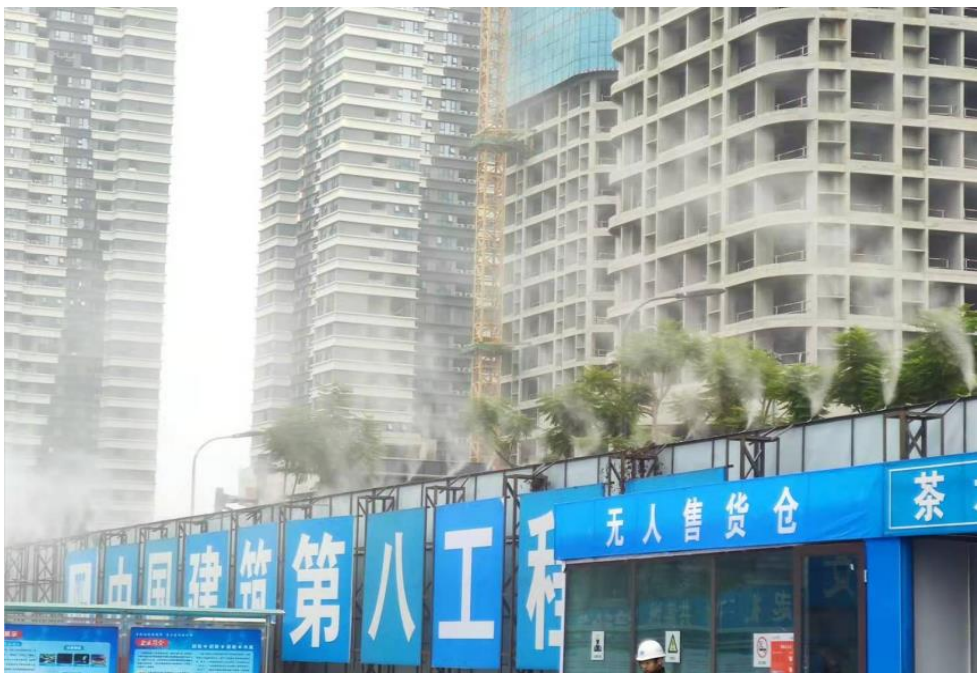
扬尘喷淋系统
