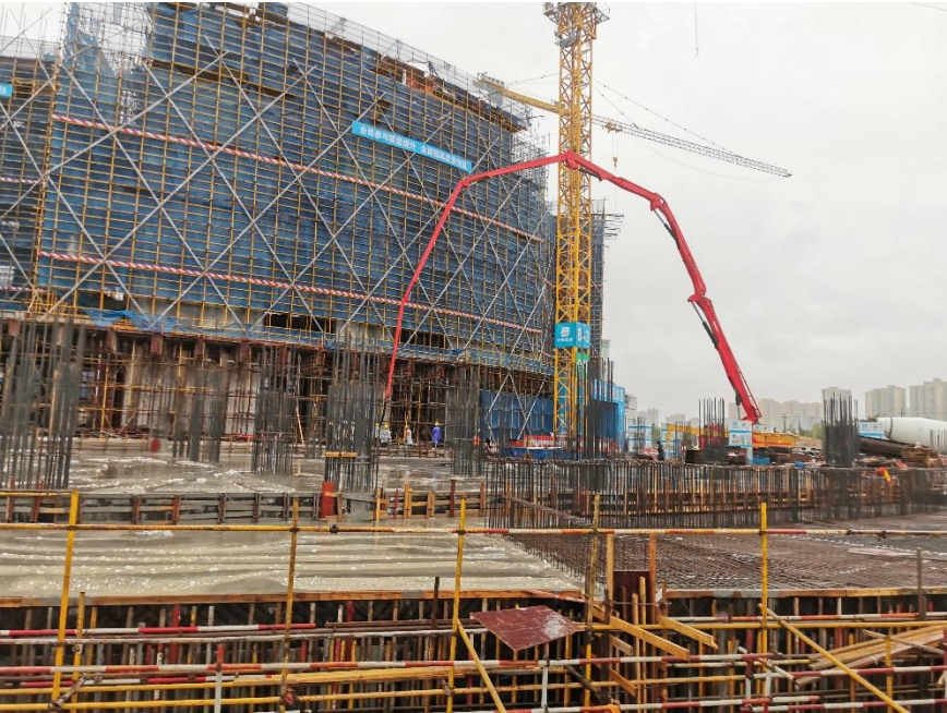
预拌商品混凝土浇筑
