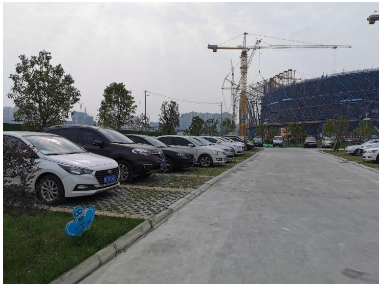
商砼临时道路
