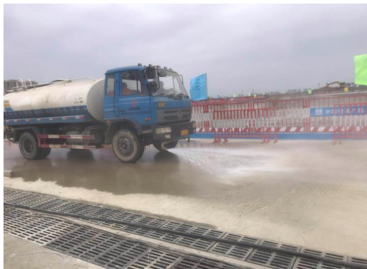
场内道路冲洗
