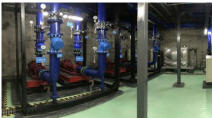
机房模块装配式安装
