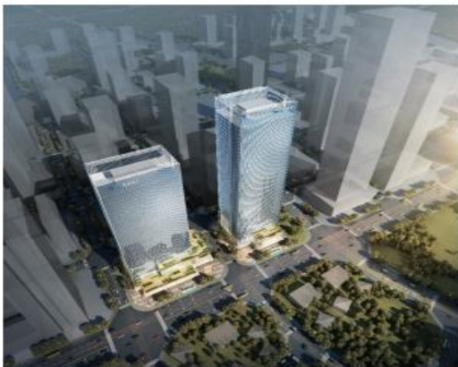
交投置地·国际创新中心 临时用电专项施工方案
