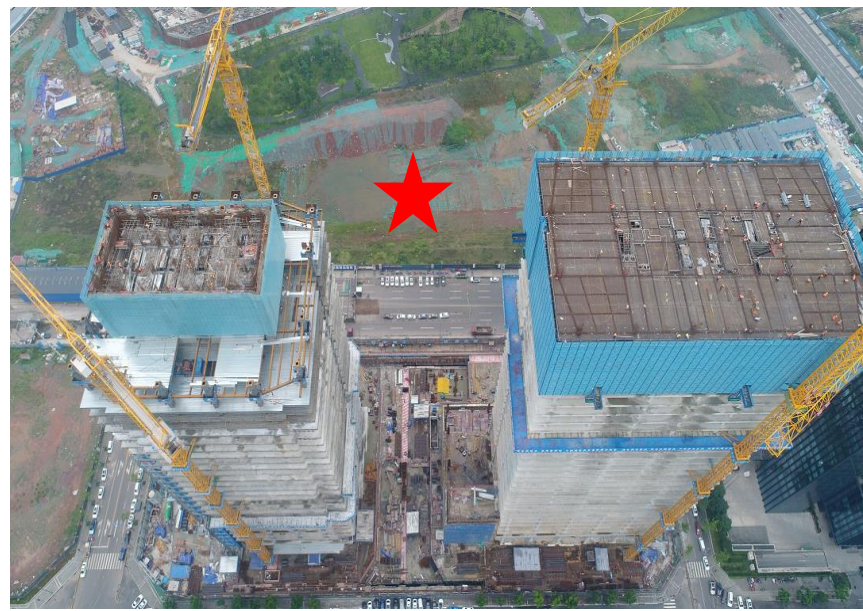
土方临时存放点
