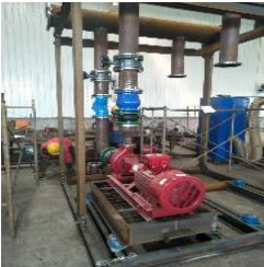
水泵模块预制拼装
