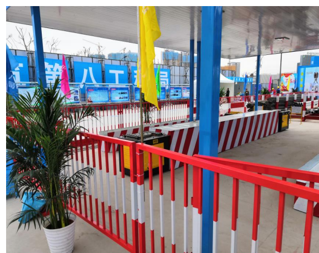
钢筋加工棚安全标志
