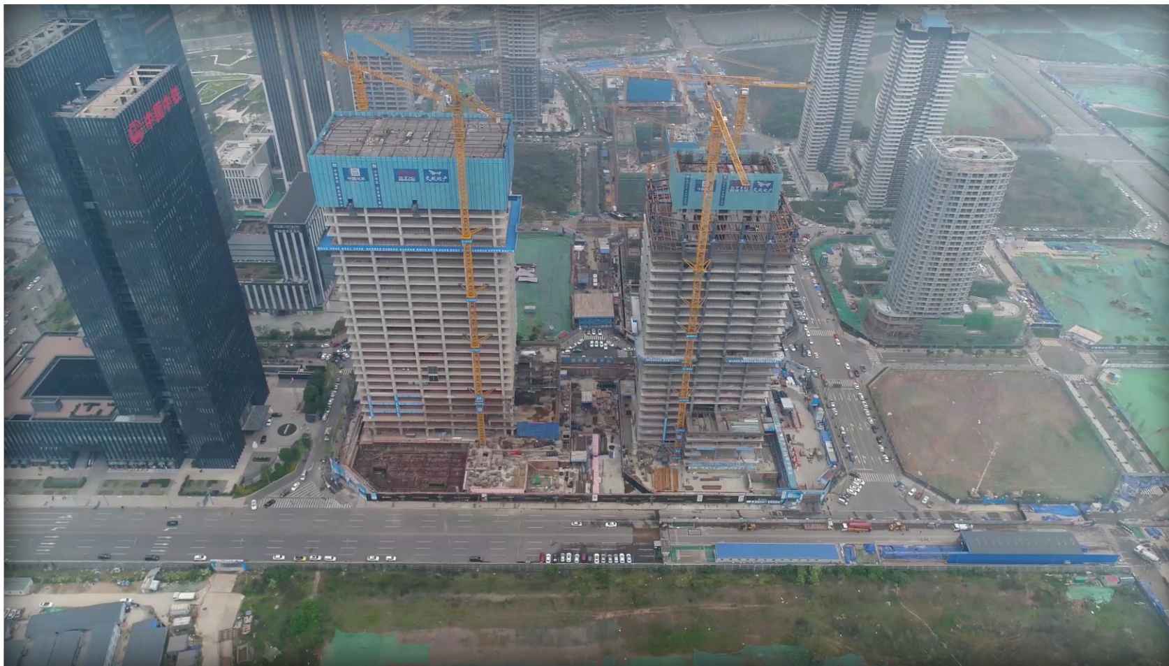
现场及生活区航拍
