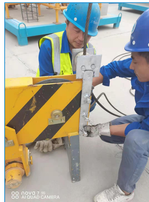
18、吊钩增加钢丝绳防跳槽装置
