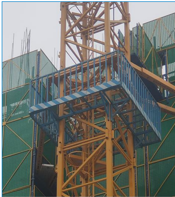
1、塔吊标准化操作平台
