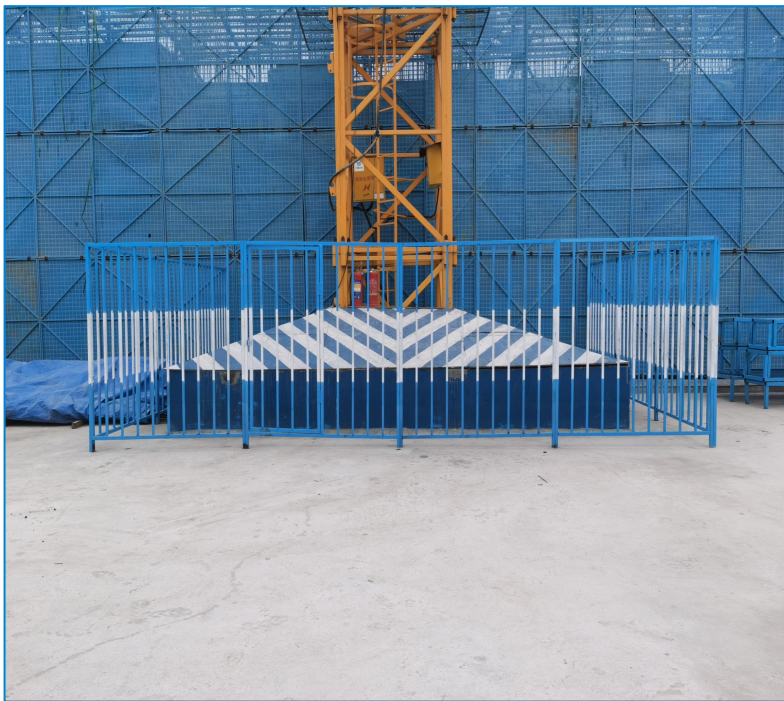
9、塔吊定型化围挡和封板及塔吊基础挡水台
