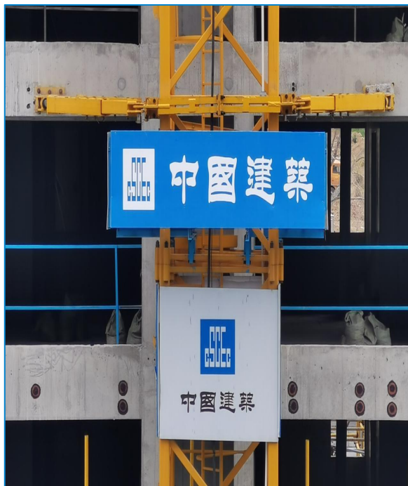
1、塔吊标准化操作平台
