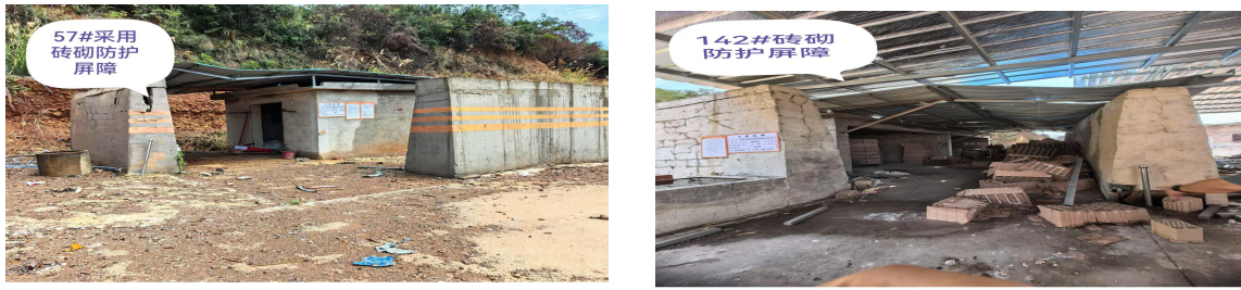
图 5 防护屏障采用砖砌结构
