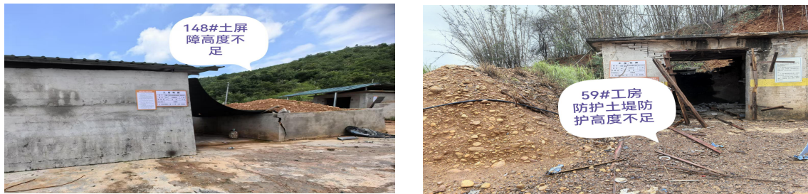
图 6 防护土堤防护高度不足
