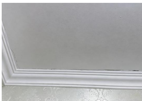
图 8.4.6-1 吊顶裂缝
