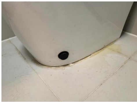
图 5.1.2-1 马桶排出口与排水管密封 图 5.1.2-2 马桶排水密封不严且 不严导致周边渗漏 发霉严重
