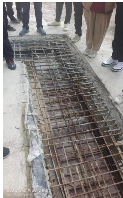
图 4.2.4-2 地下室后浇带隐蔽验收
