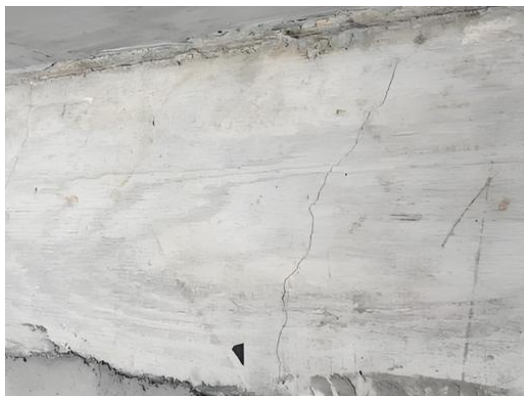
图 4.1.2-1 梁表层细微干缩缝
