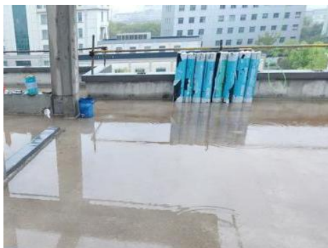
图 3.3.1-3 屋面结构蓄水试验
