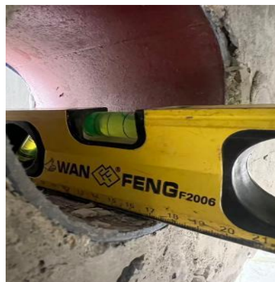
图 3.2.3-4 外墙套管坡度检查
