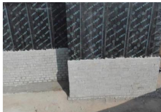
图 3.4.2-10 外墙砖砌防水保护层
