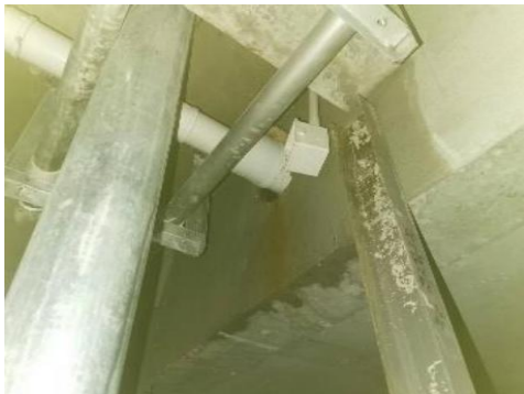
图 3.5.2-1 地下室外墙套管渗漏 图 3.5.2-2 穿外墙电缆套管封堵渗漏
