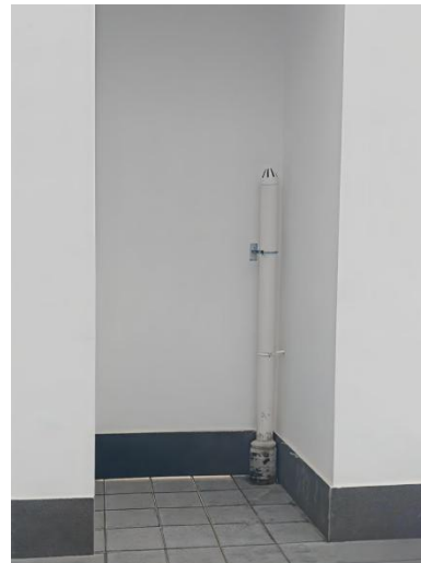
图 5.1.6-1 屋面通气管距离门过近 图 5.1.6-2 屋面通气管高度不足 且通气帽高度不足
