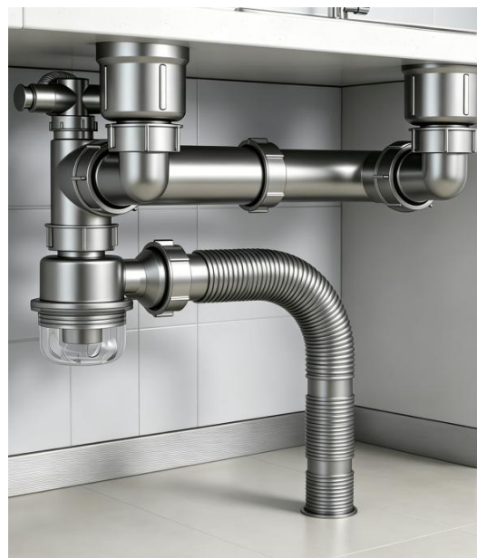
图 2.2.1-3 洗衣房排水管防反涌构造 图 2.2.1-4 台盆下水管连接优秀做法
