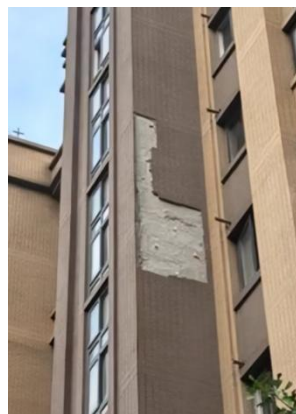
图 8.4.8-2 保温层空鼓脱落
