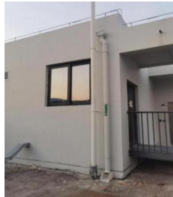
图 5.1.6-4 透气管高度规范
