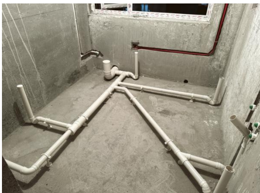
图 9.1.3-1 同层排水管道示意
