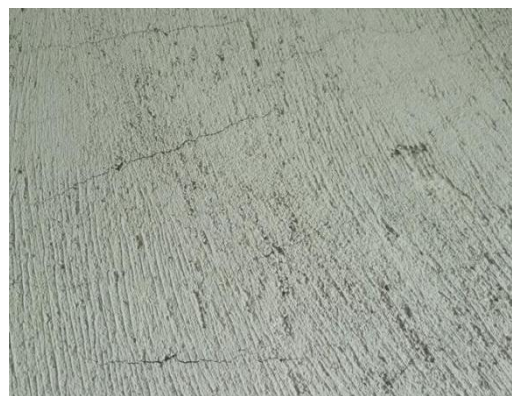
图 8.4.2-2 抹灰层开裂
