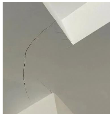
图 4.5.2-1 石膏板吊顶通长裂缝 图 4.5.2-2 石膏板吊顶角部裂缝
