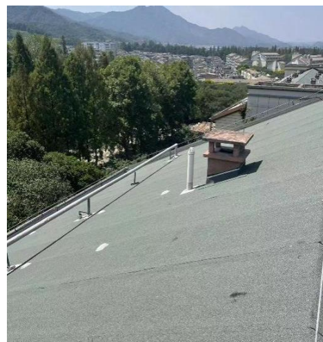
图 7.2.3-4 坡屋面整体铺设耐候卷材
