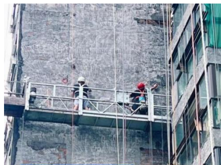
图 8.4.8-4 保温层整体置换修复
