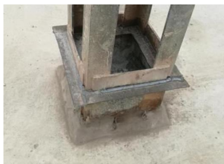
图 3.4.1-10 格构柱根部止水措施
