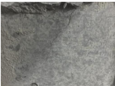
图 8.1.1-3 外墙裂缝
