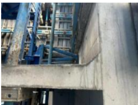
图 3.2.4-3 挑板构件结构找坡
