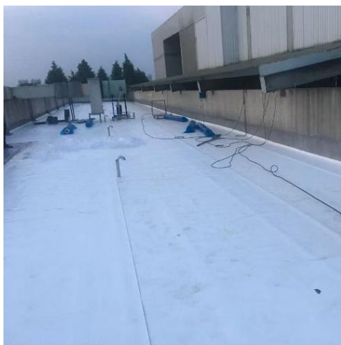
图 7.2.3-3 屋面高分子卷材铺设
