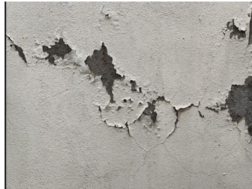
图 8.4.3-1 外墙涂料饰面层开裂 图 8.4.3-2 外墙涂料饰面层起皮脱落
