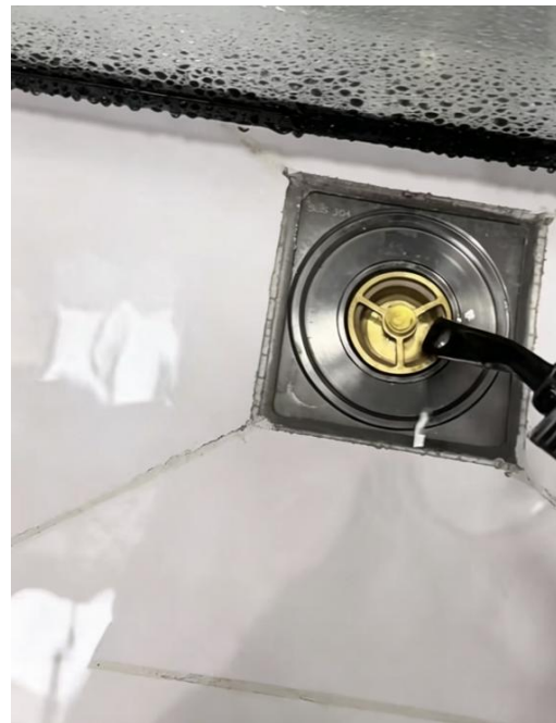
图 2.4.1-2 地漏气流堵水
