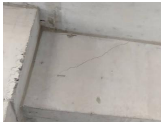
图 4.1.2-2 梁侧斜裂缝
