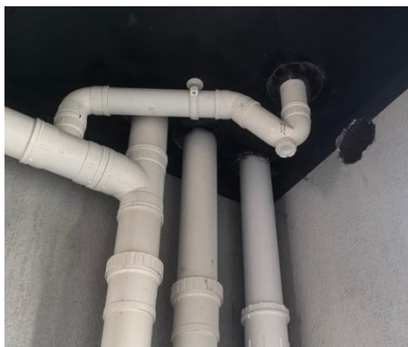
图 5.1.5-3 顶棚支管安装
