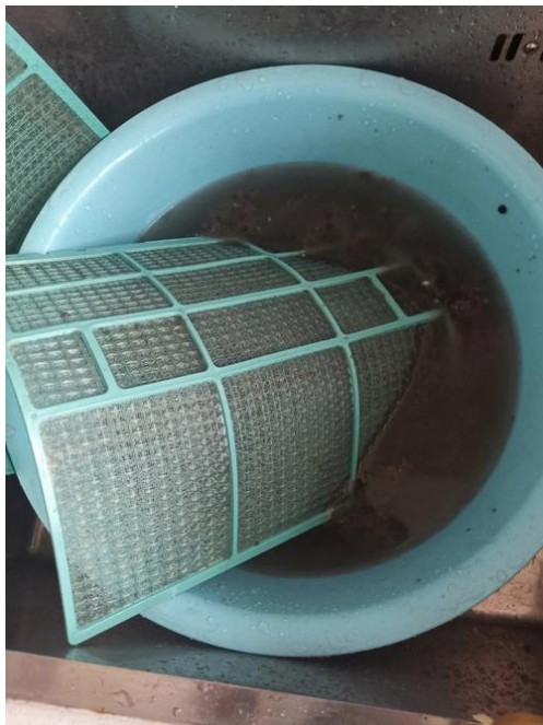
图 9.2.1-1 空调滤网清洗
