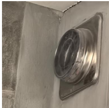
图 5.2.2-4 防火止回阀安装规范
