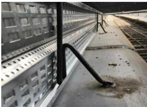
图 3.4.1-7 底板后浇带鱼鳞网片
