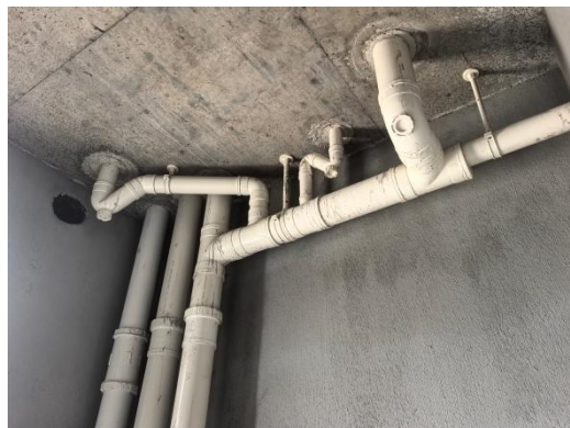
图 5.1.5-4 顶棚支管安装
