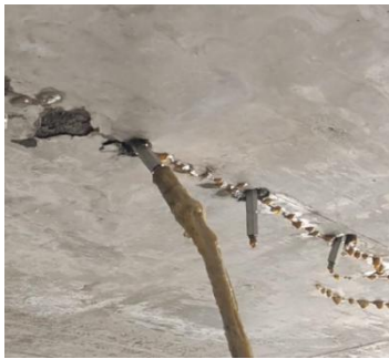
图 8.1.1-5 高压注浆修补
