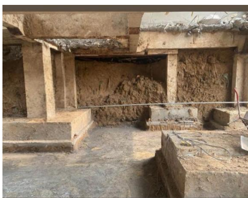
图 5.3.3-1 一层底部架空层封闭区域回填土积水返臭
