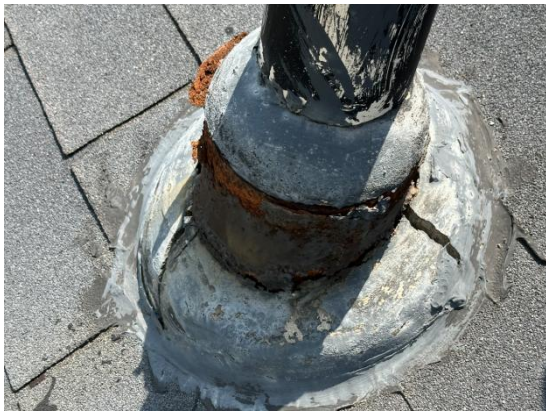
图 8.2.2-1 出屋面管道根部防水层
