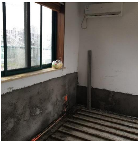
图 7.5.3-3 室外节点渗漏修复
