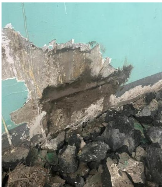
图 7.1.2-3 墙面裂缝封堵
