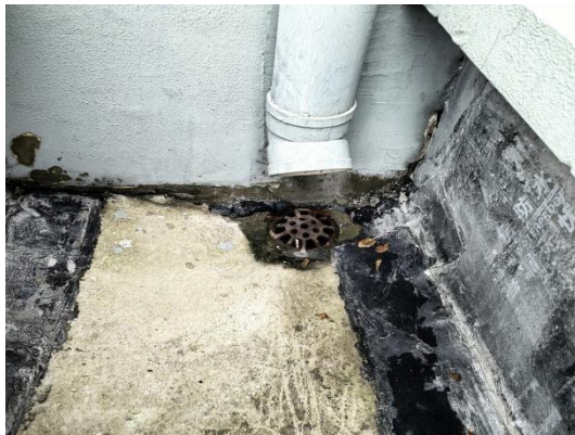
图 3.3.4-1 屋面直排雨水口
