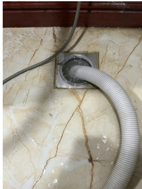
图 2.2.1-2 洗衣机排水口反涌
