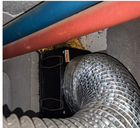
图 5.2.2-1 烟道内部接缝座浆不到位 图 5.2.2-2 止回阀与烟道连接不严密
