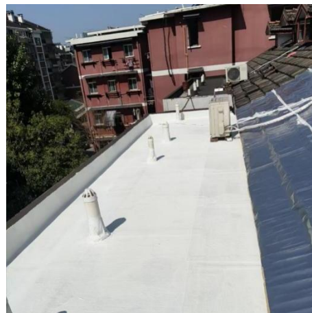
图 7.2.2-3 砖木结构瓦屋面铺设卷材 图 7.2.2-4 砖木结构天沟增设防水涂料
