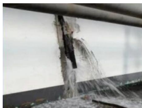
图 3.4.4-2 变形缝管涌
