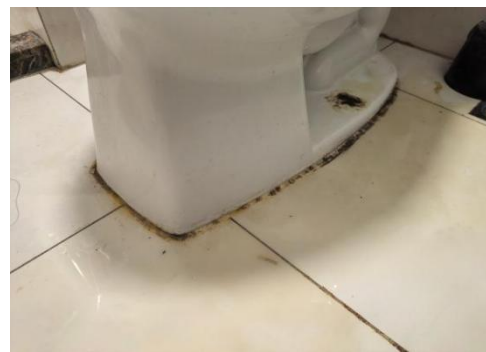
图 5.1.2-1 马桶排出口与排水管密封 图 5.1.2-2 马桶排水密封不严且 不严导致周边渗漏 发霉严重
