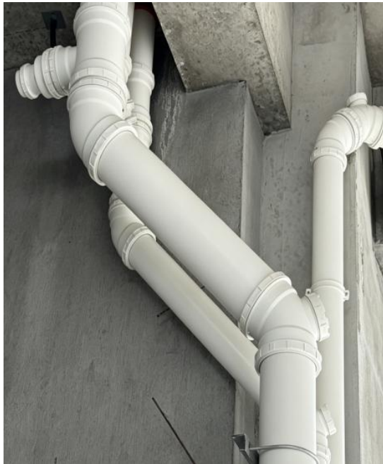
图 2.4.2-3 弯头处设置清扫口
