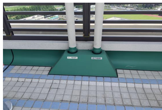
图 3.3.3-4 出屋面靠墙管道优秀做法
