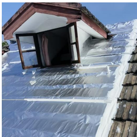
图 7.2.2-3 砖木结构瓦屋面铺设卷材 图 7.2.2-4 砖木结构天沟增设防水涂料
