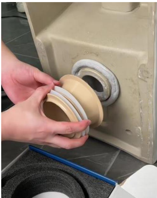
图 9.1.2-1 马桶法兰圈更换密封施工
