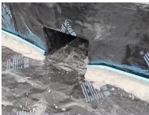
图 3.3.4-3 雨水斗防水附加层处理
