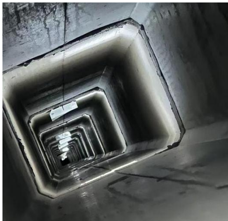
图 5.2.2-1 烟道内部接缝座浆不到位 图 5.2.2-2 止回阀与烟道连接不严密
