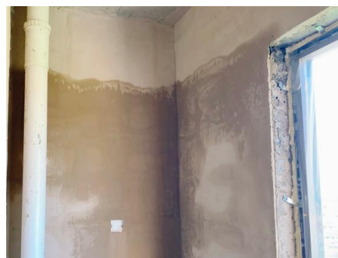
图 3.2.2-1 外墙螺杆洞封堵不饱满 图 3.2.2-2 填充墙与结构连接处渗漏
