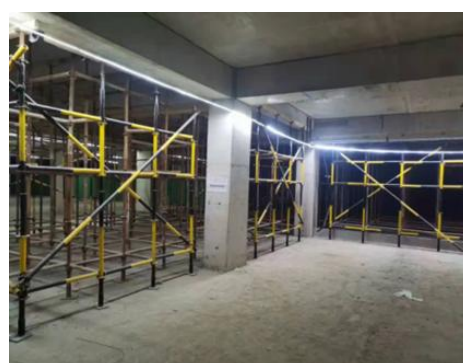
图 3.4.3-4 行车路线回顶措施
