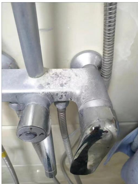
图 9.1.6-1 五金件氧化锈蚀
