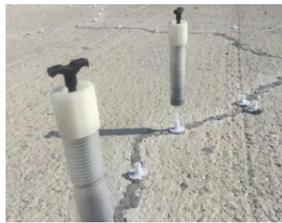
图 8.1.1-6 低压注浆修补
