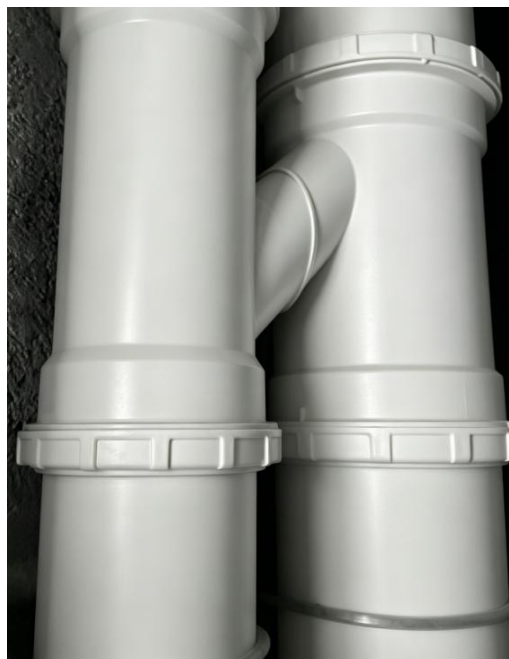
图 2.2.2-3 通气管设置标准节点
