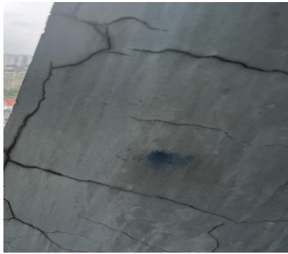
图 8.4.3-1 外墙涂料饰面层开裂 图 8.4.3-2 外墙涂料饰面层起皮脱落
