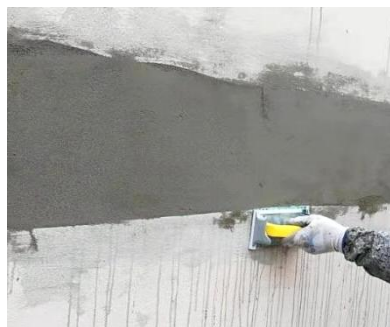
图 8.4.8-3 保温层局部置换修复
