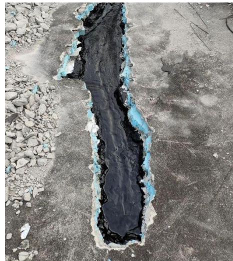
图 8.2.3-2 屋面裂缝修补
