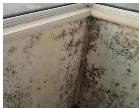
图 3.6.3-2 窗台下口结露发霉
