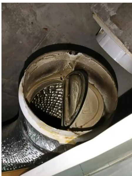
图 9.2.2-1 排气道止回阀卡滞
