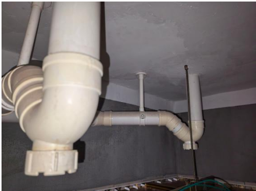
图 5.1.1-5 排水支管水封优秀做法
