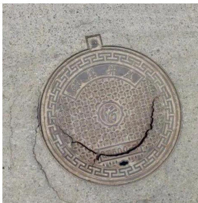
图 9.4.2-1 污水井破损
