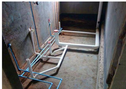
图 9.1.3-2 同层排水管道示意
