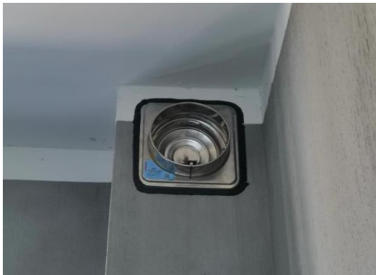
图 5.2.2-3 防火止回阀安装规范
