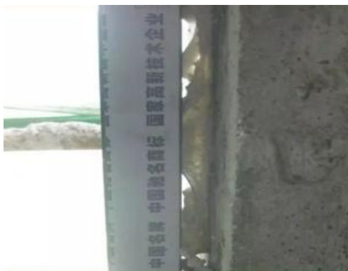
图 3.2.1-1 发泡剂充填不密实
