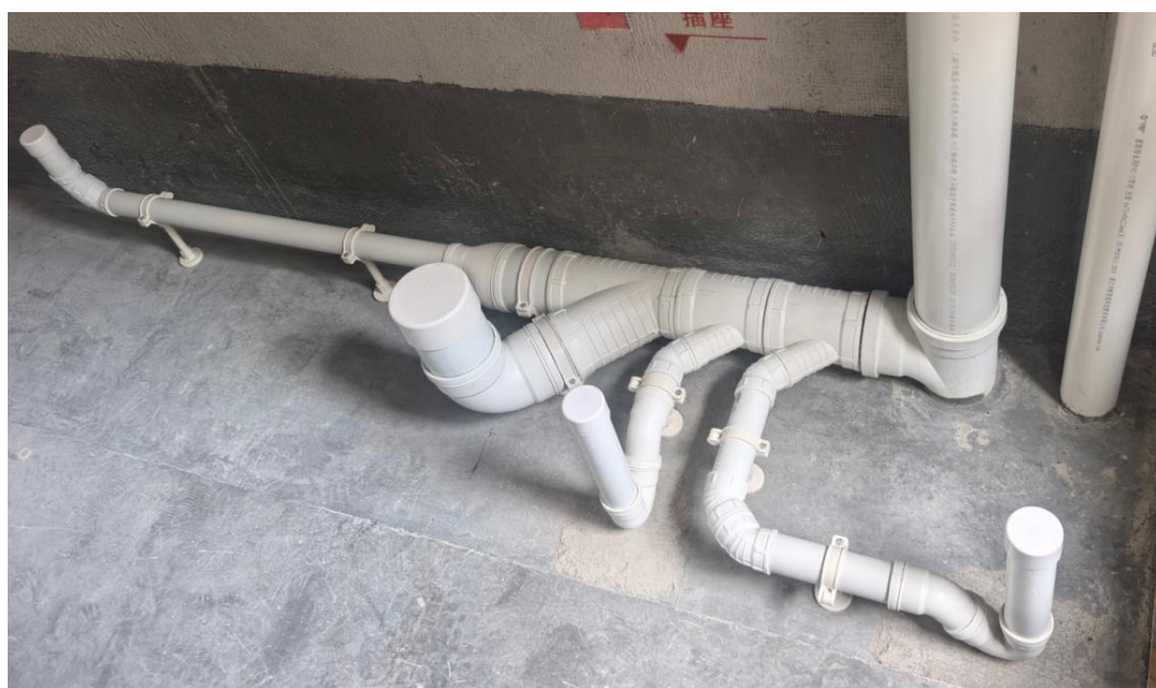
图 5.1.3-3 同层排水管道安装图示例
