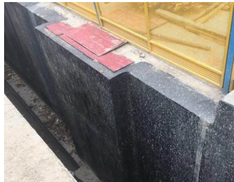
图 3.4.2-8 地下室外墙超前止水
