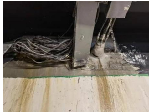
图 3.5.2-1 地下室外墙套管渗漏 图 3.5.2-2 穿外墙电缆套管封堵渗漏
