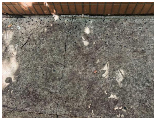
图 8.5.2-2 散水裂缝
