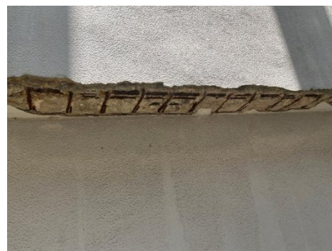
图 8.1.2-1 柱钢筋锈蚀、保护层胀裂 图 8.1.2-2 梁钢筋锈蚀、保护层胀裂
