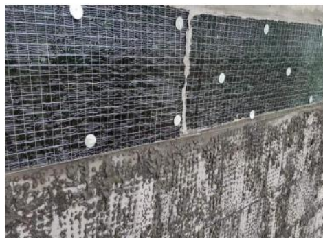
图 8.3.1-4 防水抗裂带
