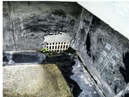
图 3.3.4-2 屋面侧排雨水口
