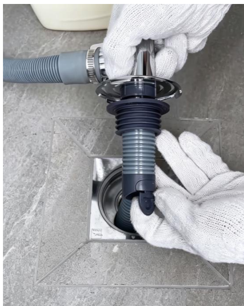
图 2.2.1-3 洗衣房排水管防反涌构造 图 2.2.1-4 台盆下水管连接优秀做法
