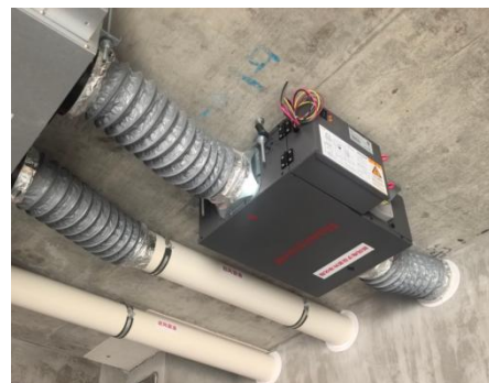
图 5.2.1-4 柔性短管安装示意
