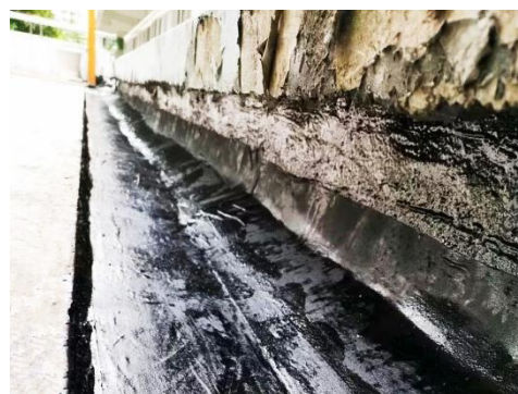
图 3.3.2-2 屋面变形缝渗漏维修
