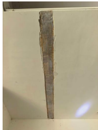
图 8.4.6-4 吊顶裂缝补强修整
