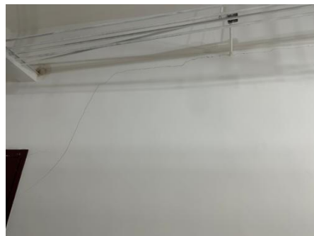
图 8.3.3-2 填充墙裂缝
