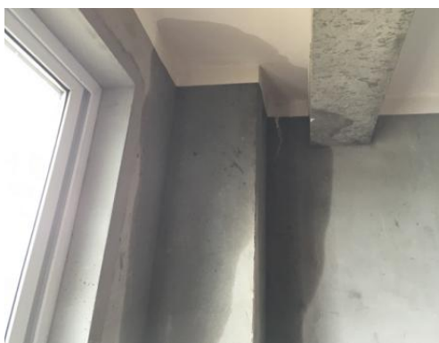
图 3.1.3-1 排气道渗漏
