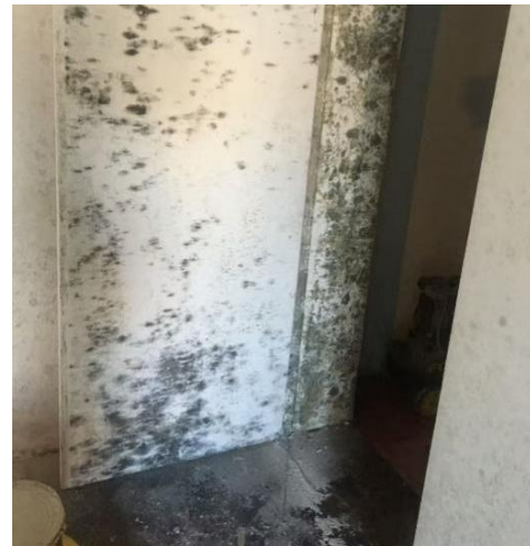
图 7.5.2-2 一层室内门框严重发霉
