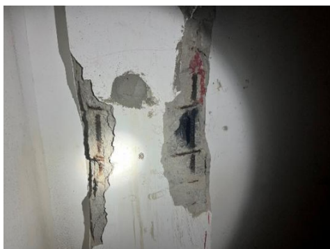
图 8.1.2-1 柱钢筋锈蚀、保护层胀裂 图 8.1.2-2 梁钢筋锈蚀、保护层胀裂
