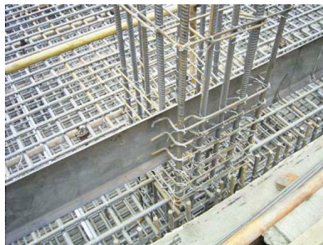
图 3.4.1-8 后浇带止水钢板穿柱
