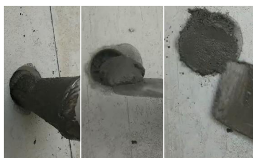
图 3.2.2-3 外墙螺栓孔封堵
