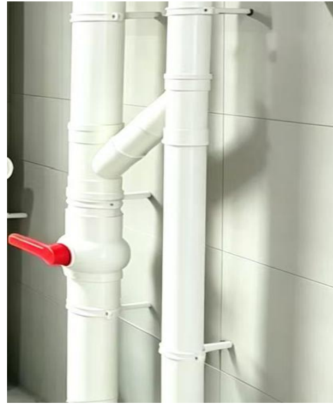
图 2.4.4-4 低层排水溢流装置
