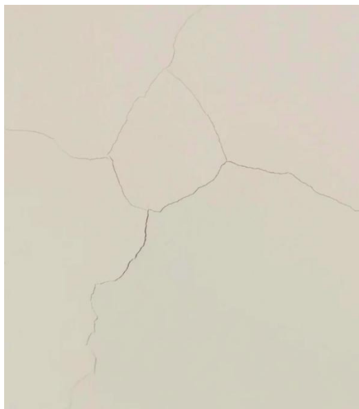
图 4.5.3-1 涂料饰面层裂缝
