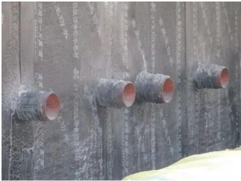
图 3.5.2-4 套管根部防水及附加层
