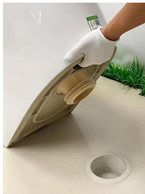
图 2.2.2-4 洁具安装示意
