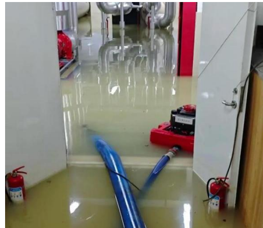
图 6.3.1-2 应急水泵排水作业
