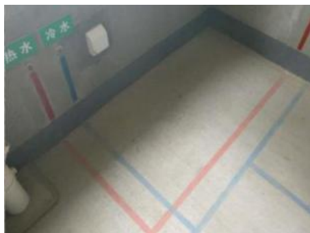
图 3.5.3-3 埋地管管路标识
