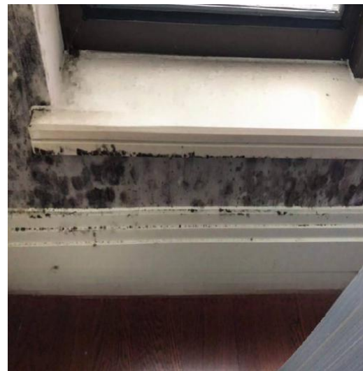
图 7.5.3-2 室内墙体结露及发霉
