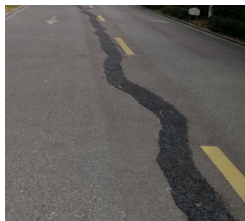
图 4.6.1-1 小区内混凝土路面裂缝 图 4.6.1-2 小区内沥青路面裂缝
