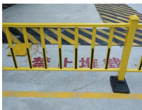
图 3.4.3-3 顶板堆载区域划分
