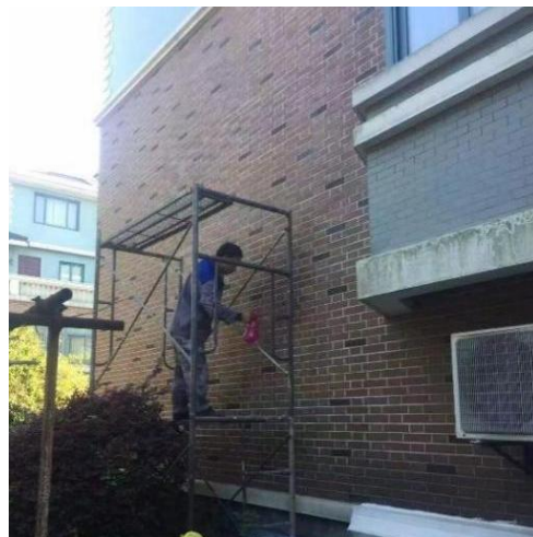
图 7.5.3-4 外立面墙体防渗处理
