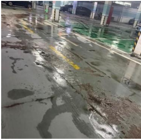
图 7.1.1-1 后浇带渗漏
