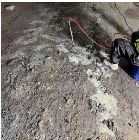
图 7.1.1-3 后浇带化学注浆
