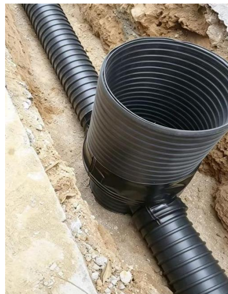
图 2.3.3-4 塑料管井接头做法
