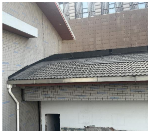
图 7.2.1-4 瓦屋面局部铺设卷材
