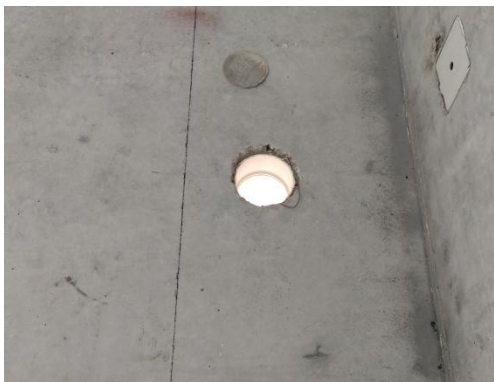
图 3.2.3-3 穿墙管道结构预埋套管
