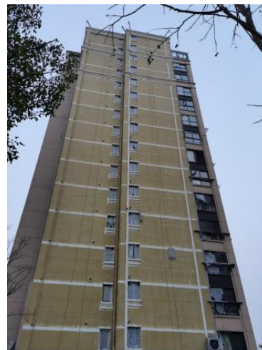
图 8.4.8-5 外保温附加柔韧层修复构造 图 8.4.8-6 外保温附加柔韧层修复
