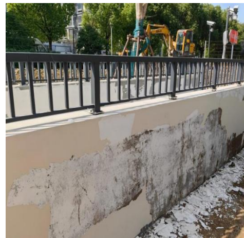
图 8.4.3-3 外墙外保温开裂修复构造示意 图 8.4.3-4 外墙涂料饰面层铲除
