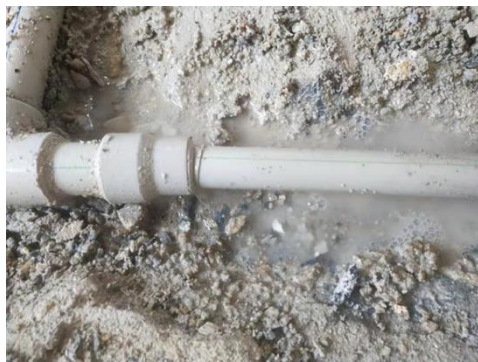
图 3.5.3-1 埋地管连接部位渗漏 图 3.5.3-2 不锈钢管焊接部位渗漏
