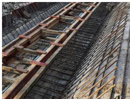
图 3.4.1-6 后浇带超前止水施工
