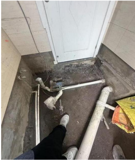
图 7.4-3 卫生间湿区拆除翻修
