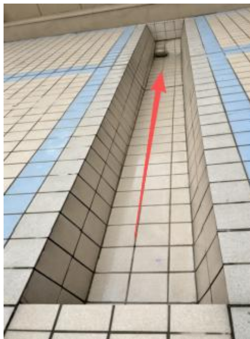
图 2.1.1-4 屋面天沟排水坡度示意
