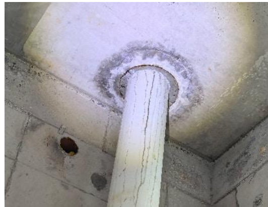
图 8.2.2-2 出屋面管道根部环向裂缝
