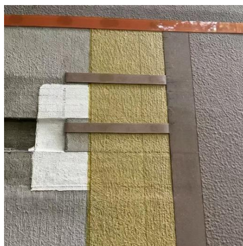
图 7.3-4 窗节点框架边基层处理
