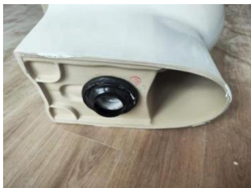
图 5.1.2-3 马桶密封圈安装
