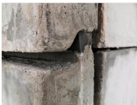
图 3.2.2-5 PC 外墙节点防水胶条
