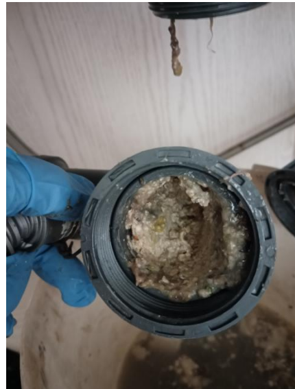
图 9.1.1-2 台盆排水构件检修更换
