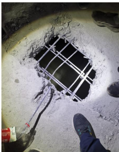
图 9.3.3-1 夹层积水腐烂返臭
