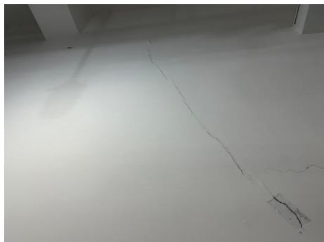
图 8.3.3-1 填充墙裂缝
