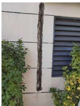
图 8.3.1-3 开槽修补裂缝
