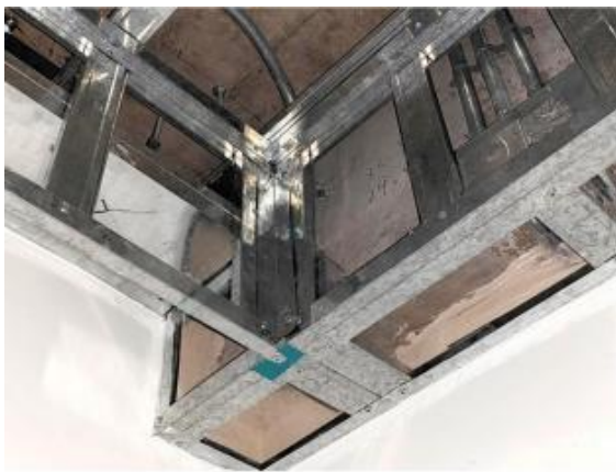
图 8.4.6-3 转角处龙骨搭接抗裂构造
