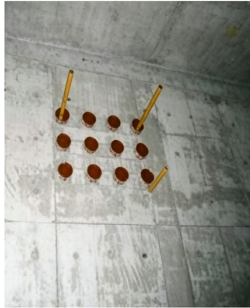
图 2.4.5-2 穿墙孔洞优秀做法
