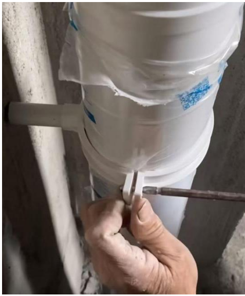
图 2.4.4-3 立管管卡固定
