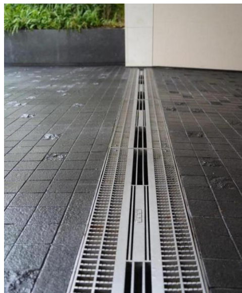
图 2.3.2-4 盖板铺装优秀成品
