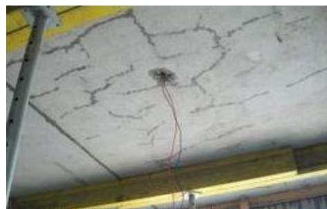
图 4.7.1-2 叠合板裂缝
