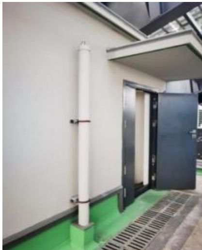
图 5.1.6-1 屋面通气管距离门过近 图 5.1.6-2 屋面通气管高度不足 且通气帽高度不足
