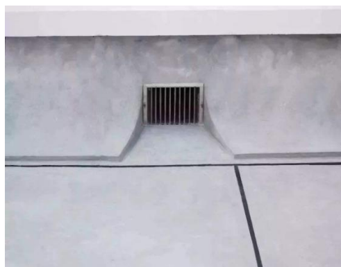
图 3.3.4-4 屋面排水口面层优秀做法
