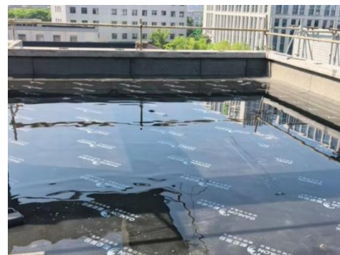
图 3.3.1-4 防水施工后蓄水检查
