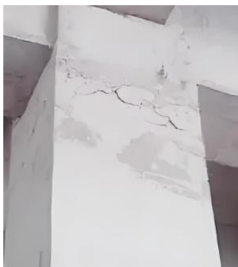
图 4.1.3-1 柱水平裂缝
