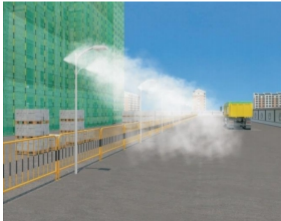
施工道路喷淋（立柱式）
