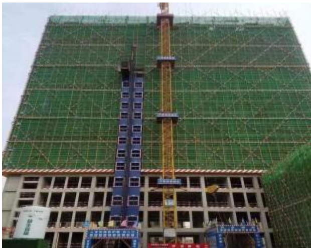
密目式安全网挂设示意图一
