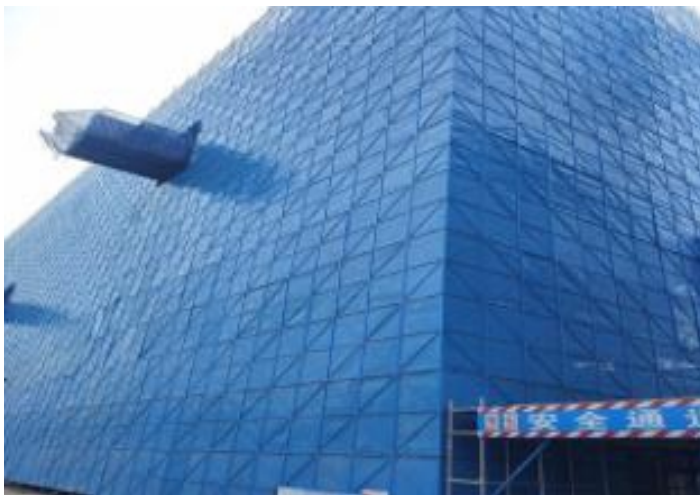
外架钢板网整体形象二
