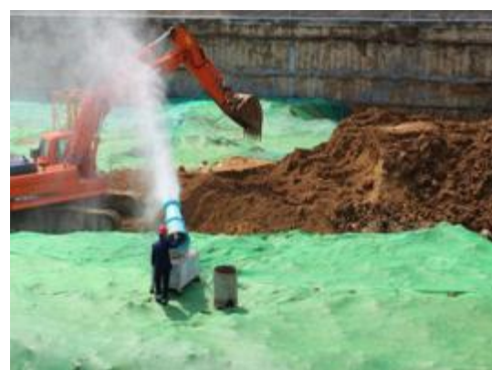
拆除工程、土石方等作业采取高压水枪、移动雾炮机降尘
