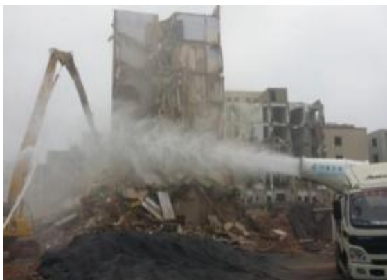
拆除工程、土石方等作业采取高压水枪、移动雾炮机降尘
