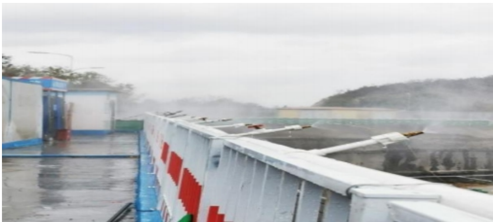
道路围挡式喷淋示例图
