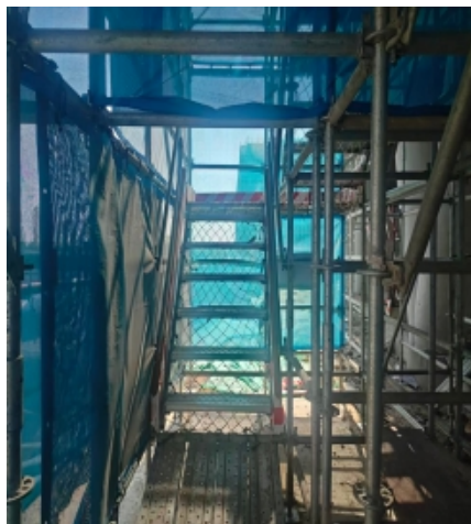
盘扣式脚手架上人通道实景图
