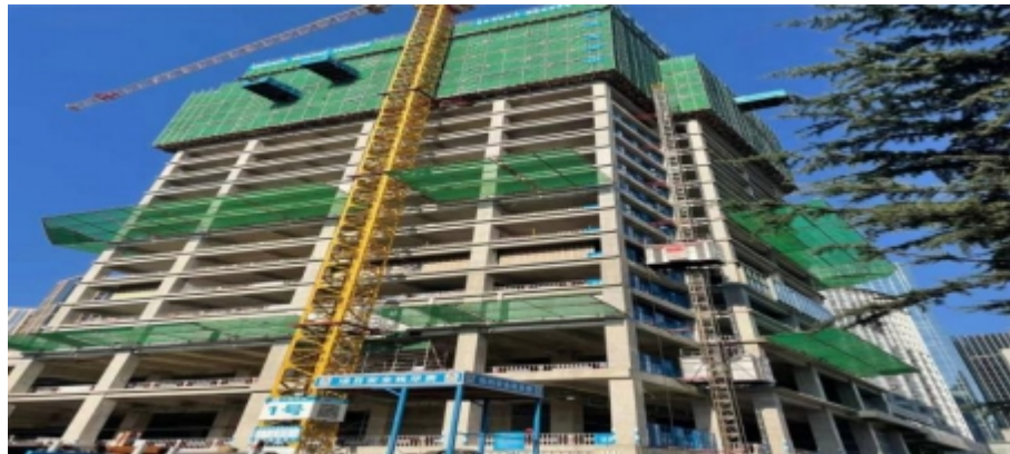
密目式安全网挂设示意图 二
