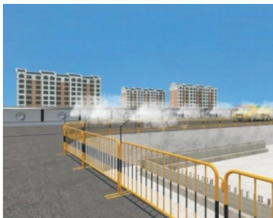
施工道路喷淋（道路围栏式）
