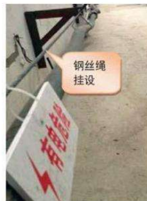
钢丝绳挂设 电缆沿工地围墙钢丝绳挂设
