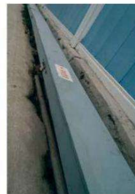
电缆桥架架设 电缆沿工地围墙电缆桥架架设
