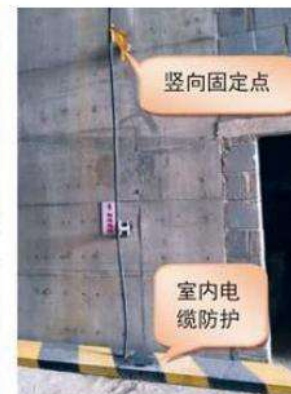
结构内电缆通过预留洞口垂直敷设电缆
