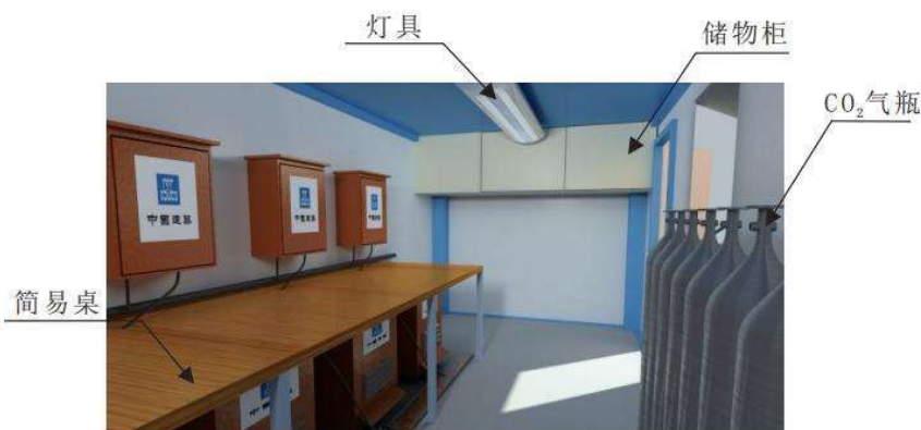
图2 焊机房内视图
