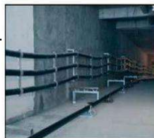
装修阶段室内电缆敷设
