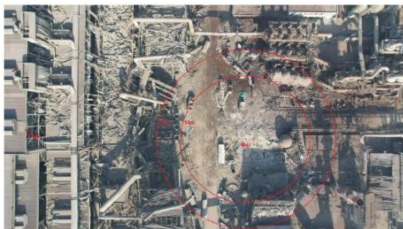
图 10 事故中心区域整体破坏情况图
