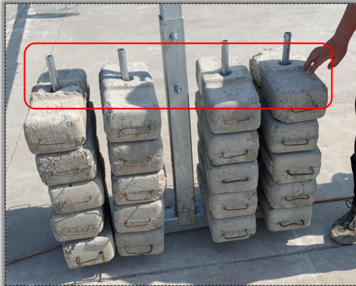
无防挪移措施，无警示标示
