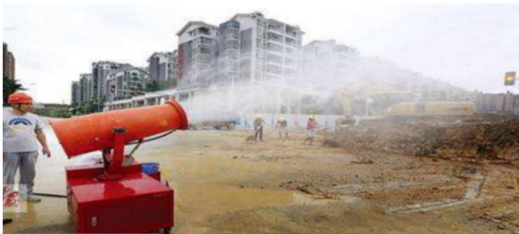
土方作业应采取防尘措施
