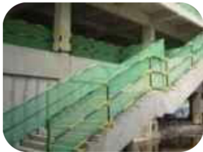
外设楼梯临边防护
