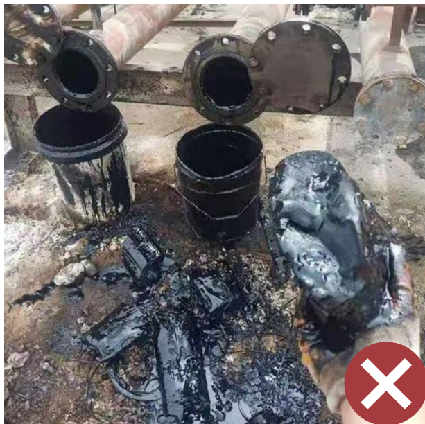
禁用结焦变质的导热油
