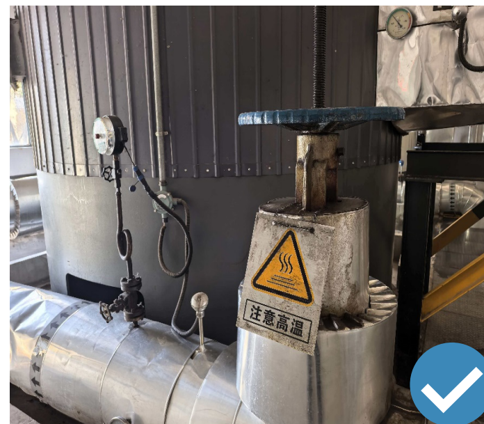
使用锻钢或铸钢材质管件阀门
