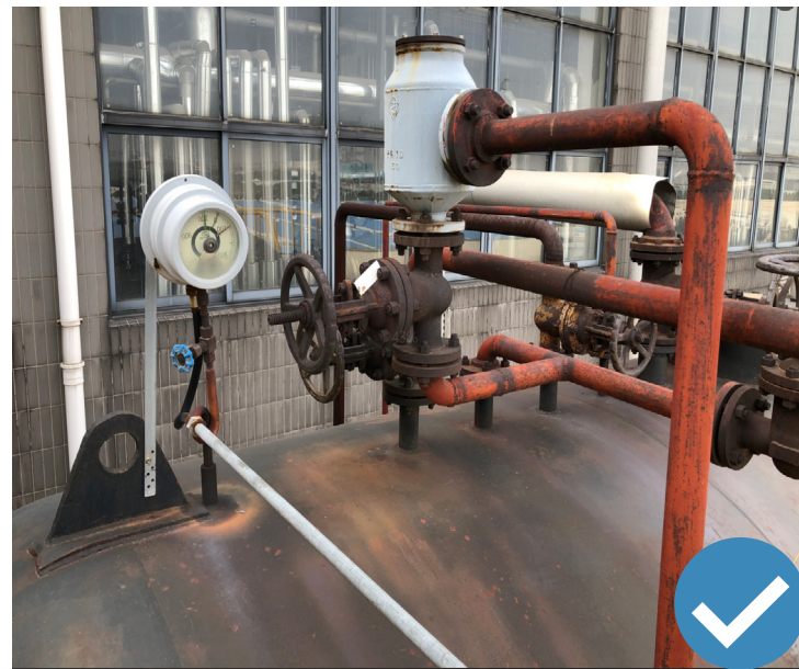
膨胀罐和储油罐均采用氮气覆盖
