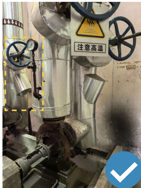
过滤器进出口压力表或设置流量检测与连锁
