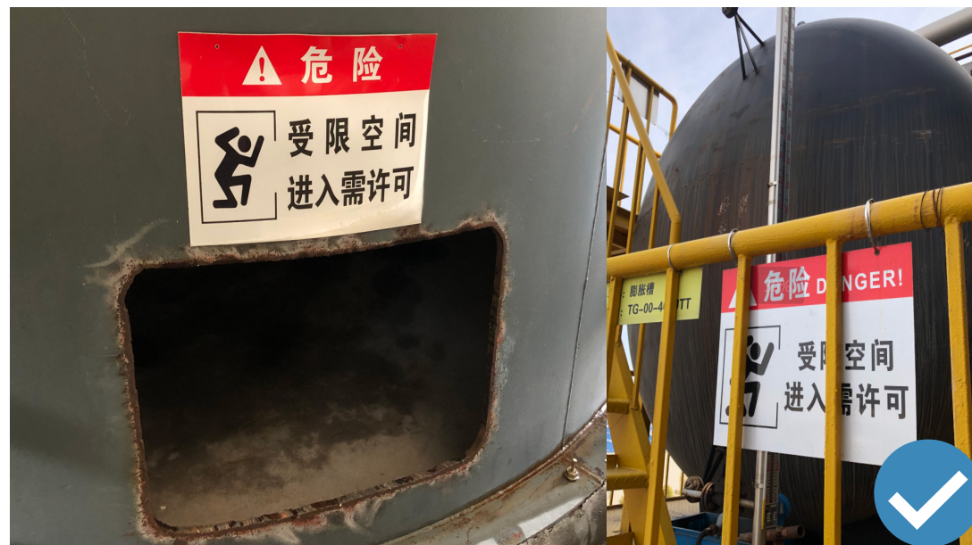
导热油炉系统受限空间辨识管理
