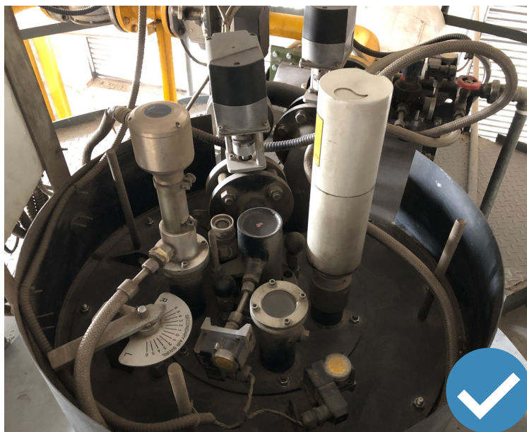
燃烧器设有观察孔及火焰监测装置、自动点火装置、熄火与燃气联锁切断及吹扫保护装置
