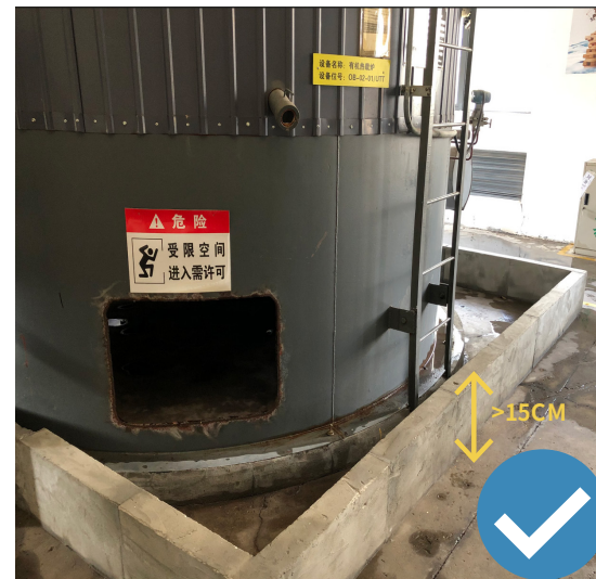
导热油炉周围设置围堰
