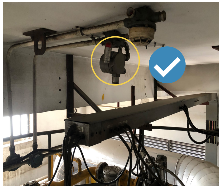
设置可燃气体检测报警仪
