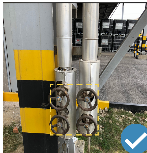
导热油排污阀、排气阀设置双阀
